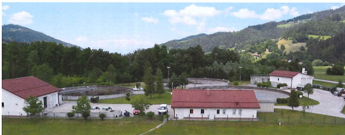
Slika 2: Centralna čistilna naprava Slovenj Gradec
